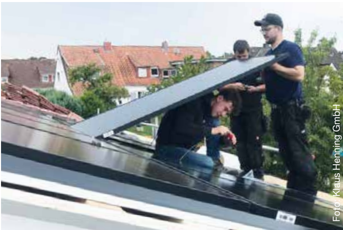
Moderne Indach-Anlagen werden statt Dachziegeln eingesetzt und fügen sich optisch perfekt ein.
