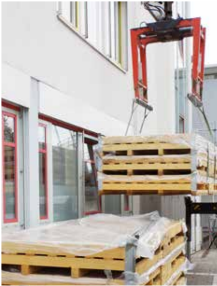
Die Fliesen werden liegend in Kisten angeliefert.
