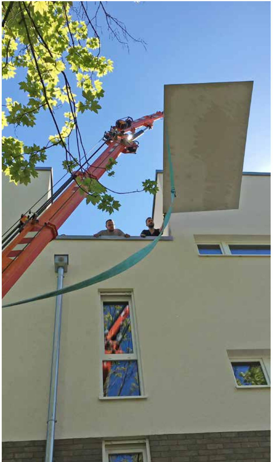
Mit dem mobilen Kran wird die Großformatfliese vorsichtig in das oberste Stockwerk gehoben.
