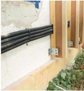
Abb. 4: Haustechnische Installationen lassen sich von außen nach-rüsten (Verlegung in der Dämmebene). Ggf. sollte die Dämm-dicke erhöht werden.
