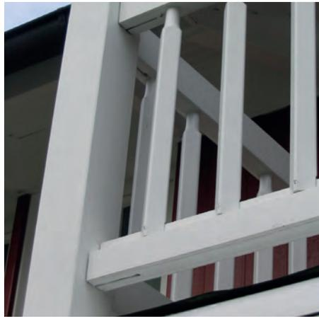
Abb. 2: Die Querriegel sind mit Luftfuge montiert und verdeckt befestigt. Der Anschluss bleibt frei von Wasseranreicherung.
