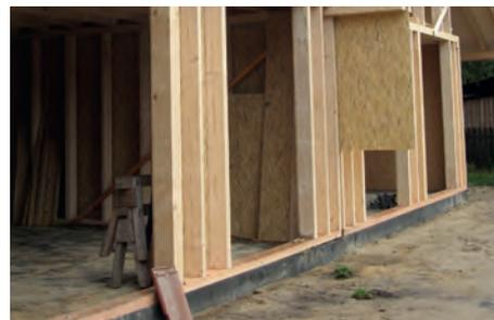
Abb. 4: Die Ausgänge zu den Terrassen sind im Rohbau angelegt. Wie wird hier das Gelände anschließen?
