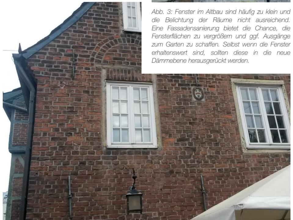
Abb. 2: Sichtmauerwerk bei einer einschaligen Wand ist bezüglich einer Innendämmung kritisch zu betrachten. Der Feuchteintrag in die Wand kann erheblich sein. Eine genaue Untersuchung ist erforderlich.
