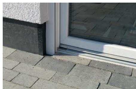
Abb. 5: Ausschnitt Abb. 4 im fertigen Zustand. Die Fußschwelle liegt hier unterhalb der Pflasterung. Eine Entwässerungsrinne vor der Fenstertür fehlt, Oberflächenwasser kann daher eindringen.
