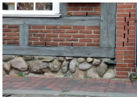
Abb. 1: Die Fachwerkschwelle ist zum Schutz vor Bodenfeuchte und Spritzwasser auf einem Steinsockel angeordnet. Und: Gefälle weg vom Haus!
