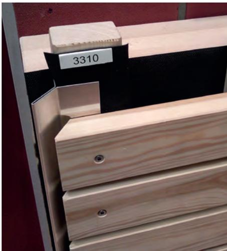
Abb. 7: Metallprofile für Fassadenecken (Y-Form) und für vertikale Fugen werden von verschiedenen Herstellern angeboten.
