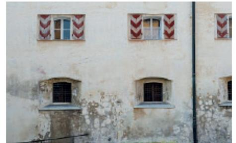
Abb. 3: Fenster im Altbau sind häufig zu klein und die Belichtung der Räume nicht ausreichend. Eine Fassadensanierung bietet die Chance, die Fensterflächen zu vergrößern und ggf. Ausgänge zum Garten zu schaffen. Selbst wenn die Fenster erhaltenswert sind, sollten diese in die neue Dämmebene herausgerückt werden.
