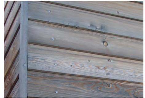
Abb. 11: Weniger gut zu bewerten ist die einfache Eckleiste. Die Profilschalung schließt hier direkt an. Die ungünstige „Wasserfuge“ vergrößert die Feuchteaufnahme des Holzes.
