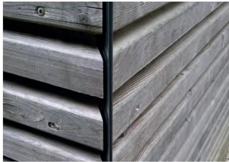
Abb. 8: Fassadenecke bei Lückenschalung mit schwertförmigem Metallprofil (Y-Form) und beidseitiger Fuge von 10 mm. Das Metallprofil ermöglicht eine saubere Fugenausbildung auch bei Verformungen der Rautenleisten und schützt zusätzlich vor mechanischen Beschädigungen.
