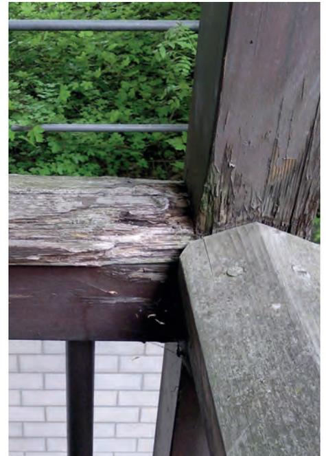
Abb. 4: Schadensbild an einer Balkonkonstruktion. Querriegel bzw. Geländerholme sind ohne Luftfuge direkt an dem Pfosten befestigt. Stetiger Wassereintritt hat hier bereits zu einer Holzzerstörung geführt.
