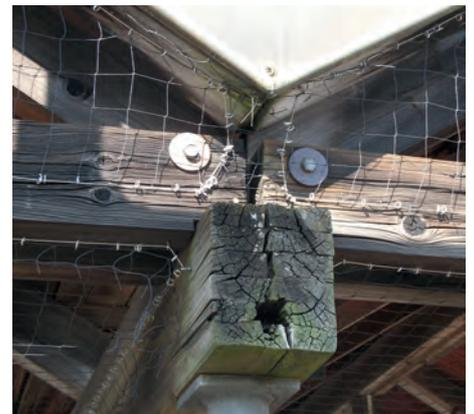
Abb. 4: Dieser Brettschichtholzträger ist am Ortgang nicht ausreichend geschützt, der Dachüberstand ist hier zu klein. Die Hirnholzfläche hätte abgedeckt werden müssen (Abb. 2 rechts). Besonders stark ist das Schadensbild an der Wetterseite.
