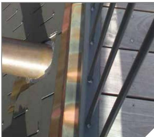
Oberflächenwasser in Verbindung mit den Holzinhaltsstoffen führte zur Verfärbung vom Kupferblech.
