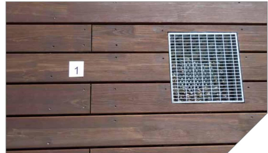
Für Wartungsarbeiten muss die Entwässerung immer zugänglich sein. Mit Entwässerungsrosten ist das einfach möglich.
