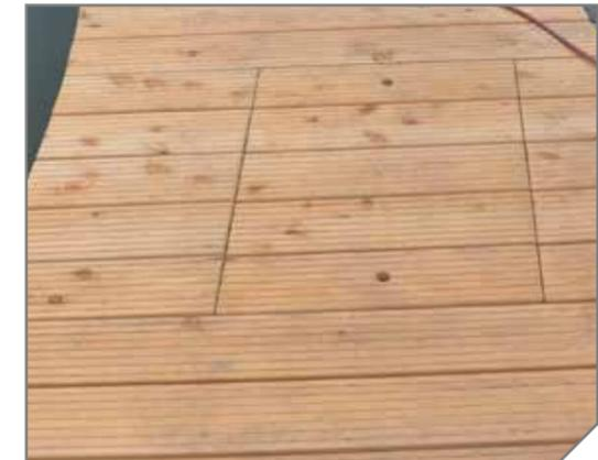
Bei Revisionsklappen aus Holz muss der bauliche Holzschutz beachtet werden.
