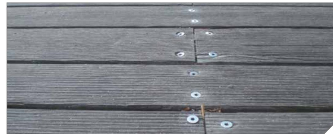
*So sollte eine Verschraubung nicht aussehen. Die Schrauben sind nicht in einer Flucht geschraubt.*
