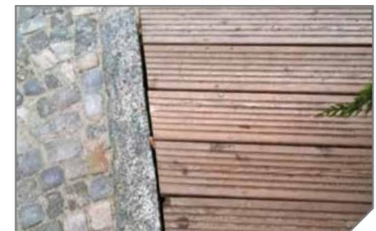
Bei Terrassen, die ebenerdig erstellt werden, sollten dauerhafte Holzarten eingesetzt werden.
