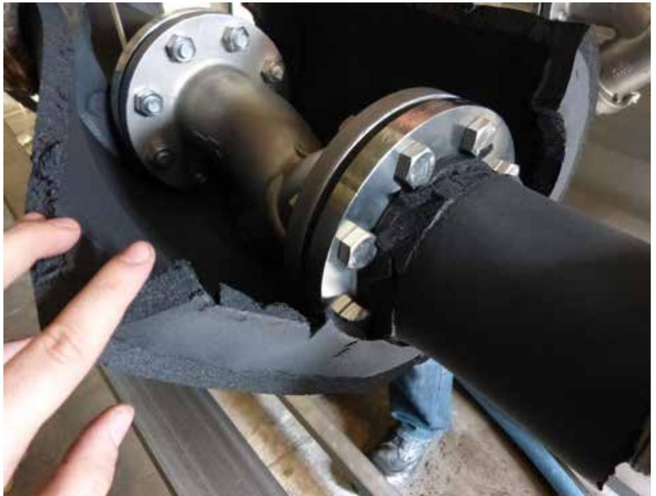
Untersucht: Korrosionsverhalten unter Dämmstoffen.
