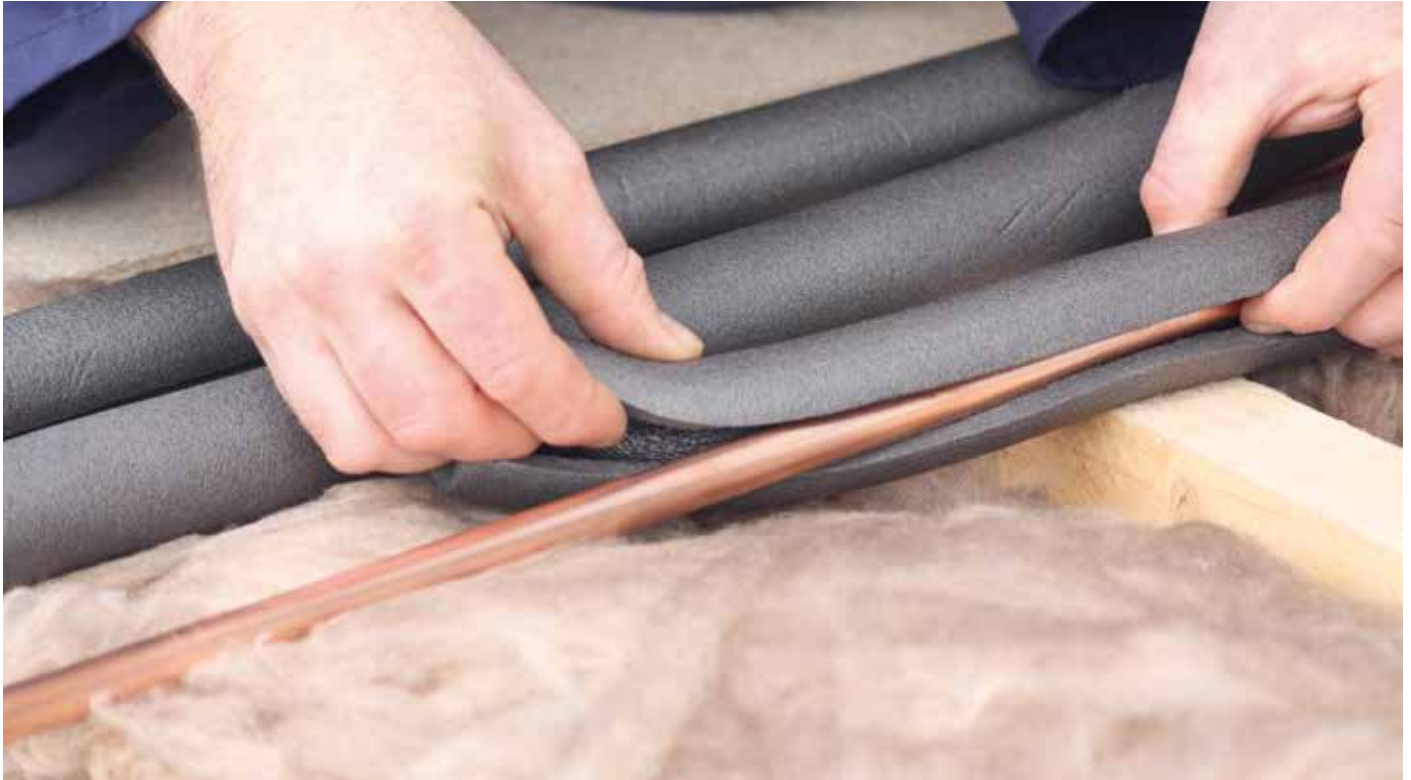
Dämmung im Handumdrehen: Eine einfache und schnelle Isolierung für wasserführende Leitungen aller Arten
