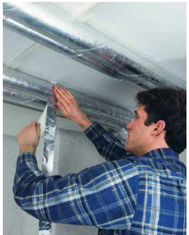
U Protect Pipe Section Alu2 ermöglicht R90 bis R120 Rohrdurchführungen von brennbaren und nicht brennbaren Leitungen.
