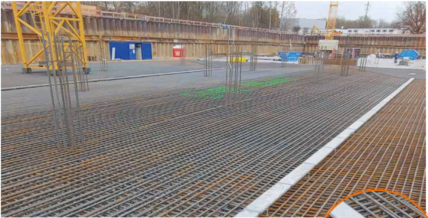
Der Bau des Aktualitätszentrum des Bayerischen Rundfunks in München mit drei Meter langen Rinnenelementen
