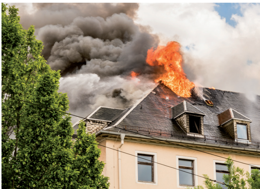
Gebäudebrände werden immer wieder durch Dacharbeiten verursacht.
