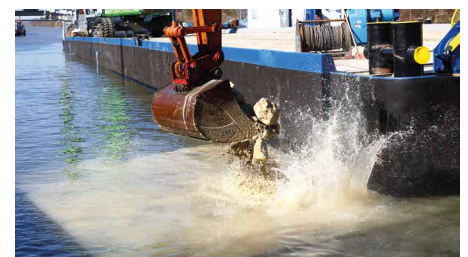
Einbringen der neuen Steinschüttung
