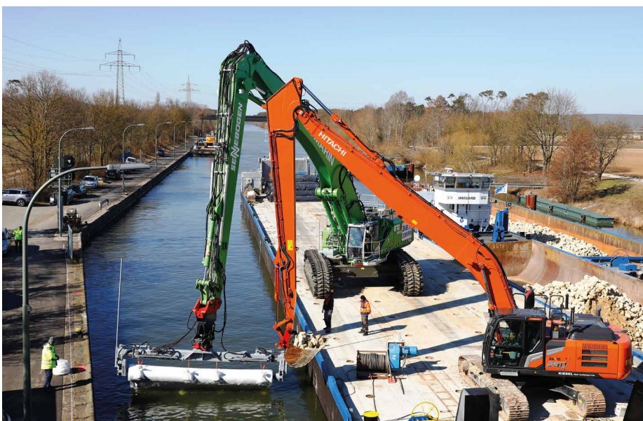
Im Zuge der Sanierungsmaßnahmen des Main-Donau-Kanals wurden in der Schleuse Strullendorf, Regnitz zum Erosionsschutz 18.100 m 2 Sandmatten eingebaut
