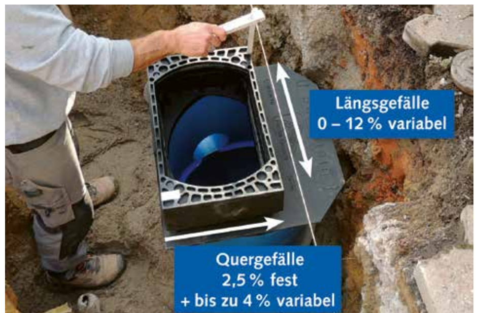
Die genaue Anpassung von Höhe und Neigung der Aufsätze an das Höhenniveau der Deckschicht ist die Grundlage für eine dauerhafte und reibungslose Funktion.
