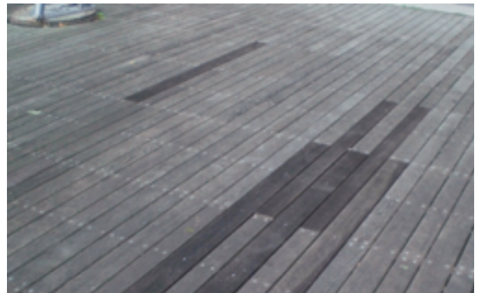
Ausgetauschte Dielen sind über einen längeren Zeitraum deutlich erkennbar.
