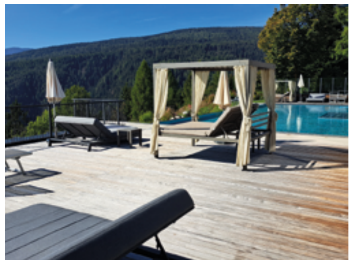
Im überdachten Bereichen von Terrassen kann die Vergrauung unterschiedlich stark ausfallen und teilweise unschön wirken.
