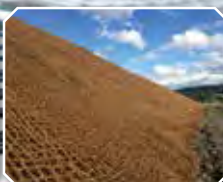
Erosionsschutz aus Jute- od. Kokosfasern
