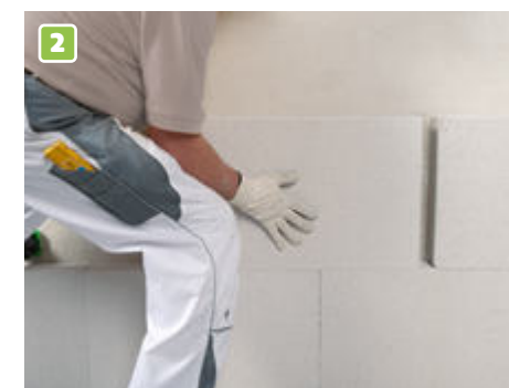
Vollflächig mit FIX X710 im Verbund verklebte Dämmplatten
