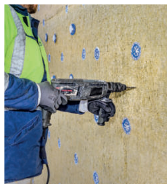
Dämmung von ca. 17.000 m 2 Außenwänden mit dem mineralischen Wärmedämm-Verbundsystem Knauf WARM-WAND Plus in 200 mm Stärke
